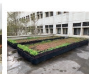
框型綠屋頂 佔地大小與車庫頂
